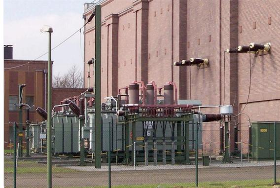
Mit Hilfe von Transformatoren lassen sich elektrische Wechselspannungen herauf- oder herunter transformieren, das heißt erhöhen oder verringern, und damit den technischen Erfordernissen des Gebrauchs anpassen. Durch diese Erfindung wurde die Übertragung von elektrischem Strom über weite Strecken mittels Hochspannungsleitungen und damit unser modernes Stromnetz erst möglich.
